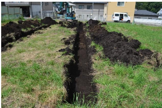
遺構が検出されたトレンチ
