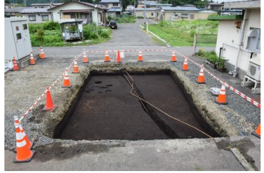
第38次調査区I全景（東から）
