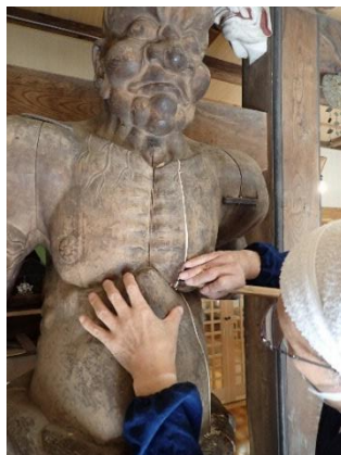
図 17 干割れ箇所の充填
