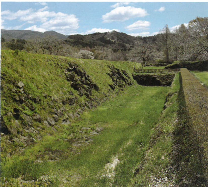
本丸南側堀の石垣
